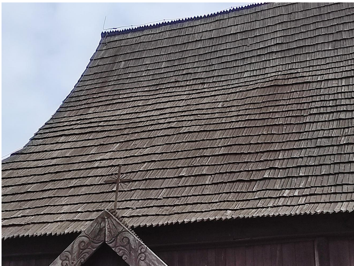
Widok zniszczonego gontowego pokrycia połaci dachowej
