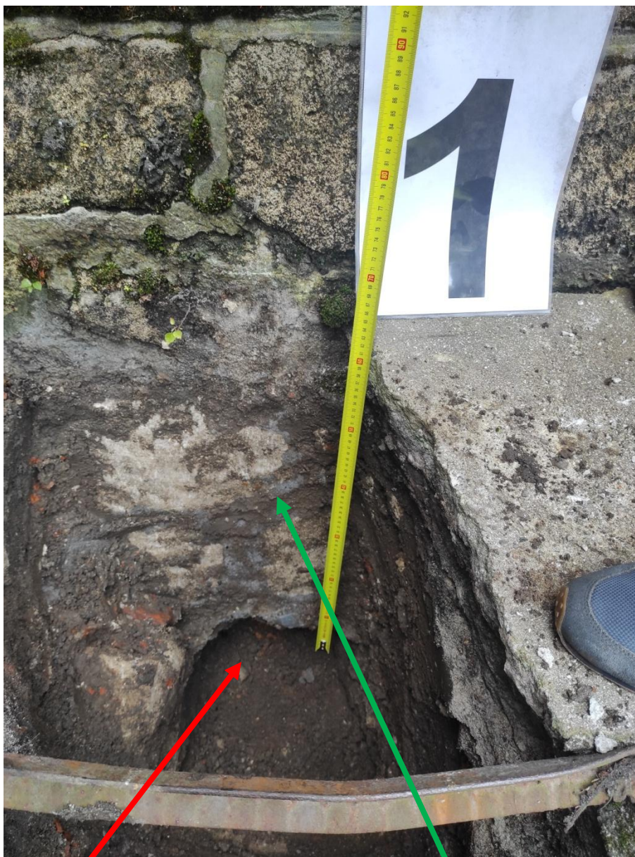
Widok zanikającego fundamentu luźny materiał skalny zmieszany z żimą
