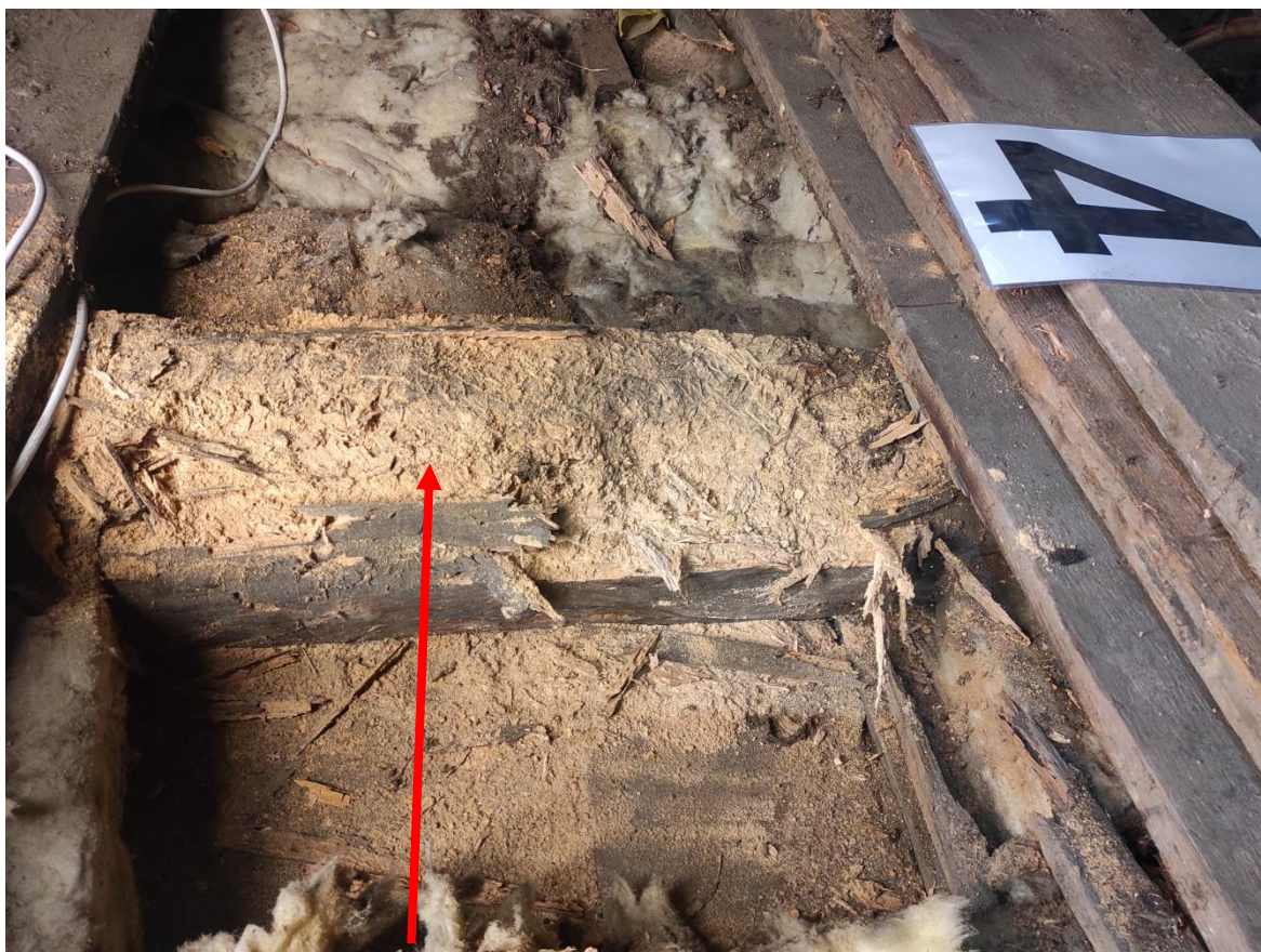
Widok zbutwiałej belki stropowej nr 4
