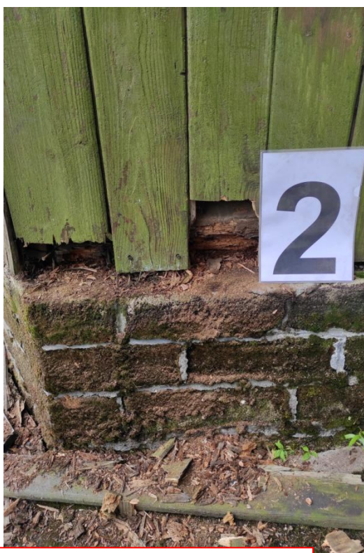
Odkrywka nr 2. – Widok zbutwiałej belki powali nowej na prezbiterium
