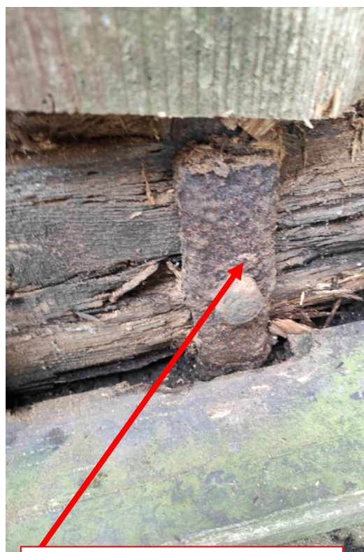
Widok wtórnego mocowania belki powalinowej
