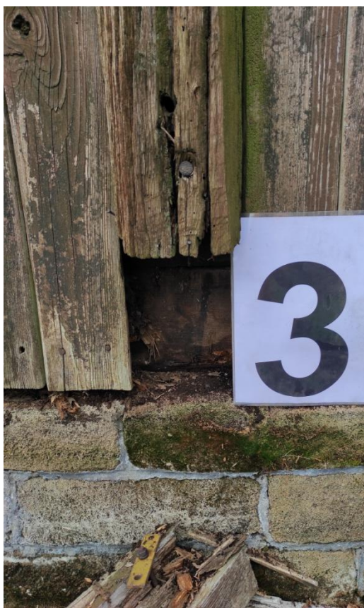
Widok zbutwiałej belki podwalinowej – odkrywka nr 3,4
