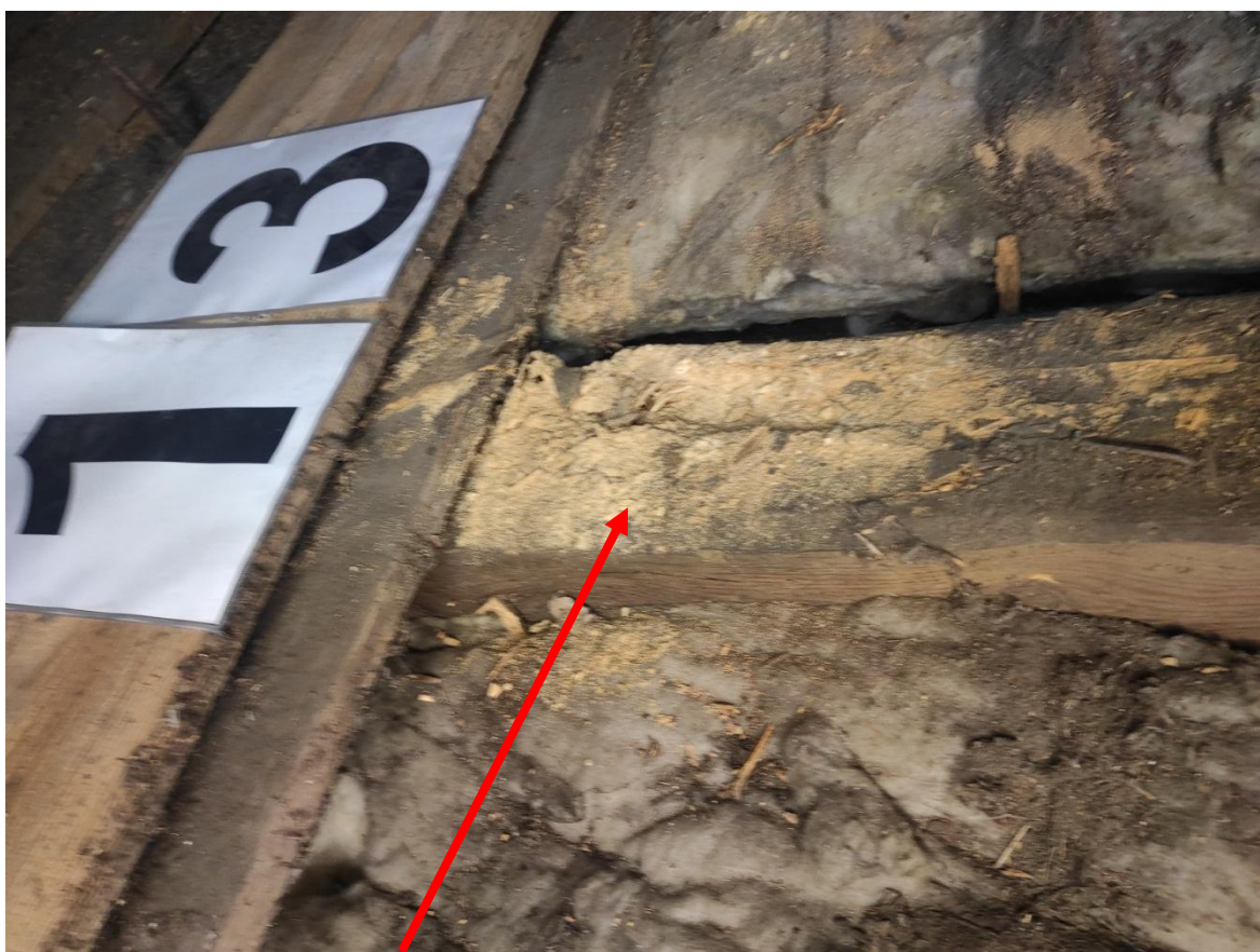
Widok zbutwiałej belki stropowej nr 13
