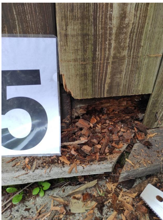
Widok zbutwiałej belki podwalinowej – odkrywka nr 5
