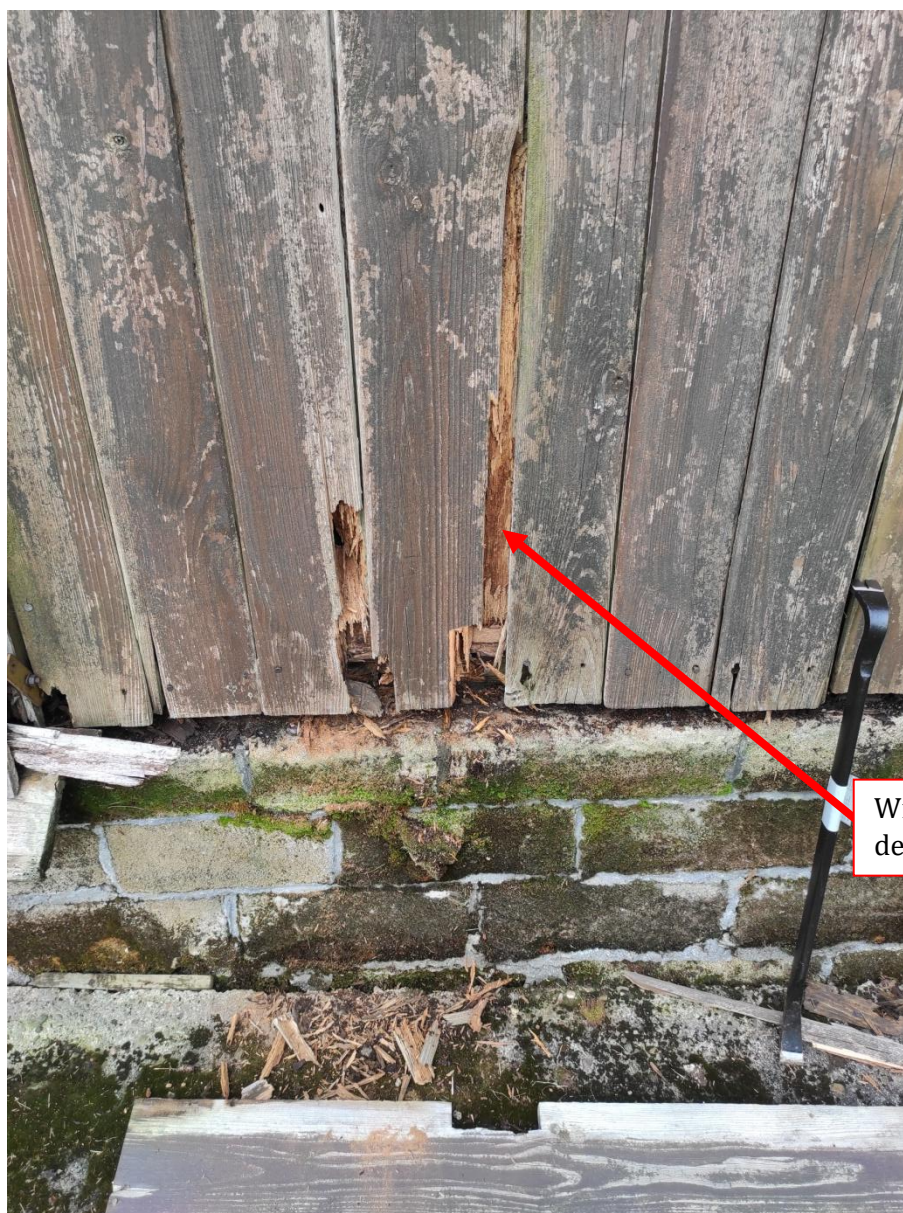
Widok zbutwiałego deskowania elewacji
