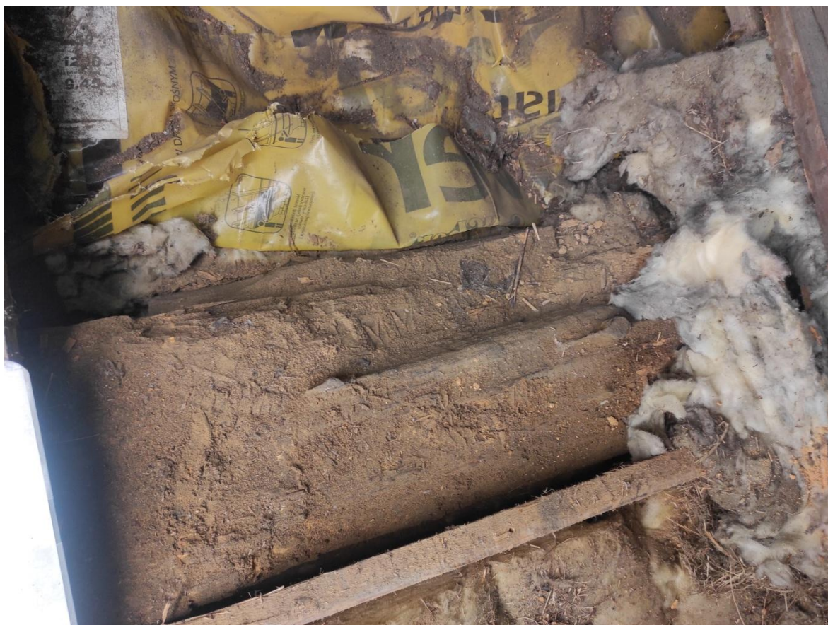
Widok zbutwiałej belki stropowej nr 2
