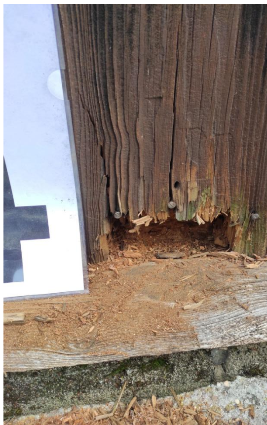
Widok zbutwiałej belki podwalinowej – odkrywka nr 3,4
