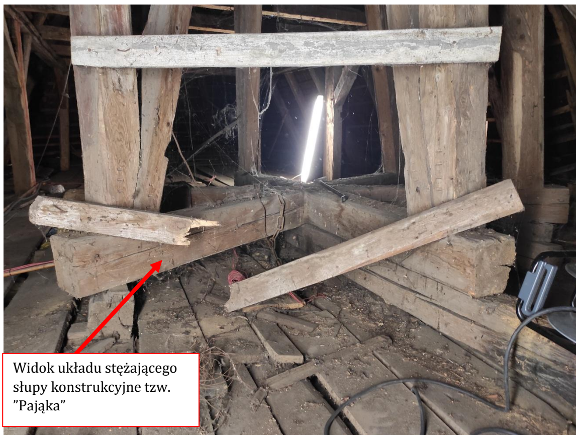
Widok konstrukcji posadowienia sygnaturki
