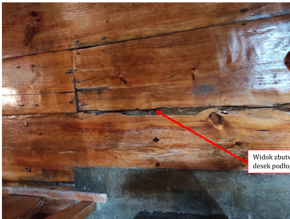
Widok zbutwiałego deskowania elewacji
