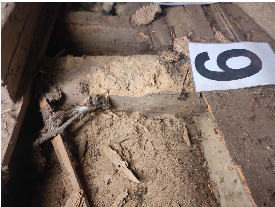
Widok zbutwiałej belki stropowej nr 9
