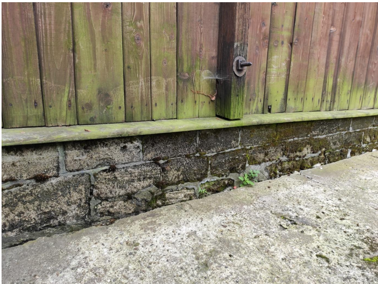
Widok podmurówki kamiennej oraz betonowej płyty odbojowej
