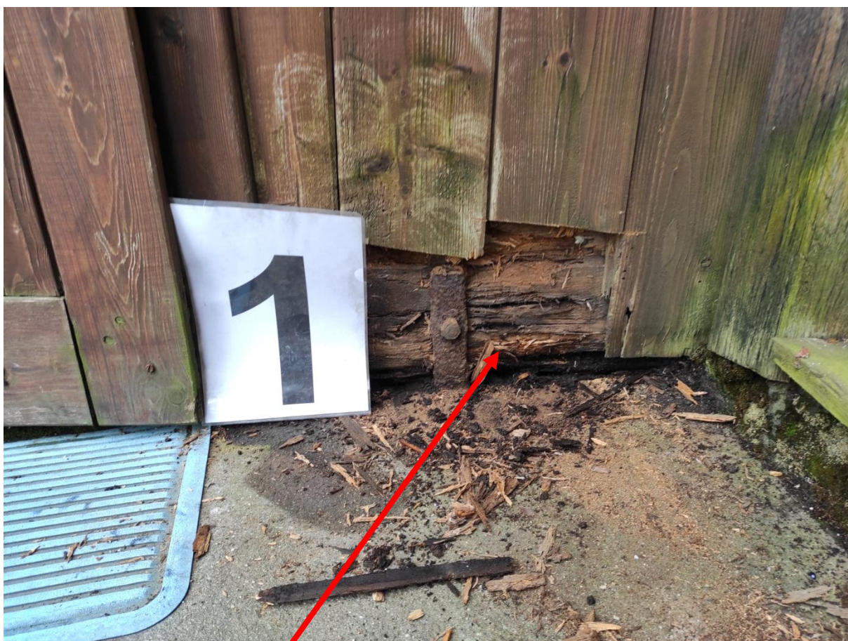
Widok zbutwiałej belki podwali nowej – odkrywka nr 1
