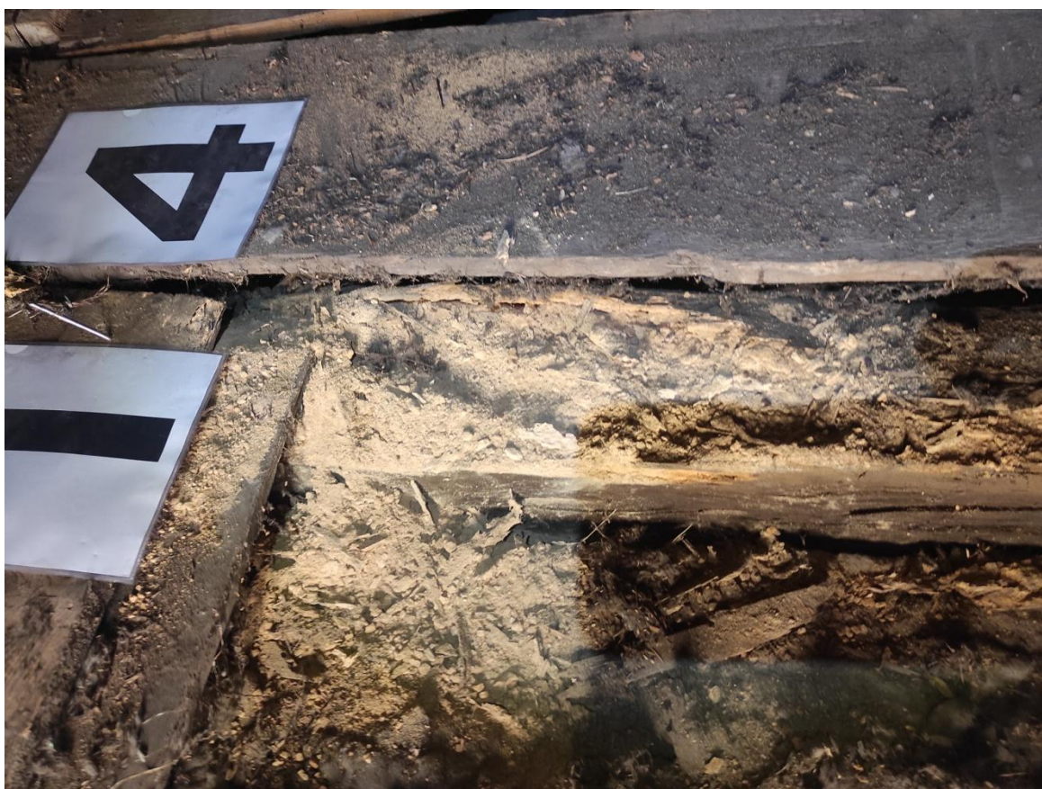
Widok zbutwiałej belki stropowej nr 14
