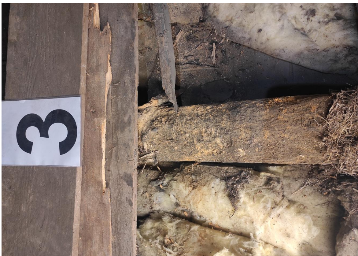
Widok zbutwiałej belki stropowej nr 2
