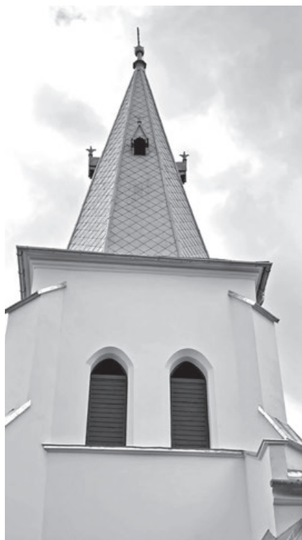
Nowe żaluzje w wieży kościoła wykonane na wzór historycznych, zamontowane w miejsce zniszczonych dotychczasowych elementów
