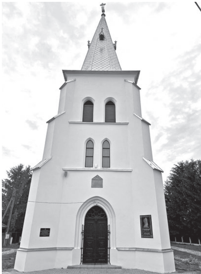
Widok od frontu świątyni z odnowionymi głównymi drzwiami wejściowymi, przeszkleniami witrażowymi oraz nowymi żaluzjami w wieży kościoła
