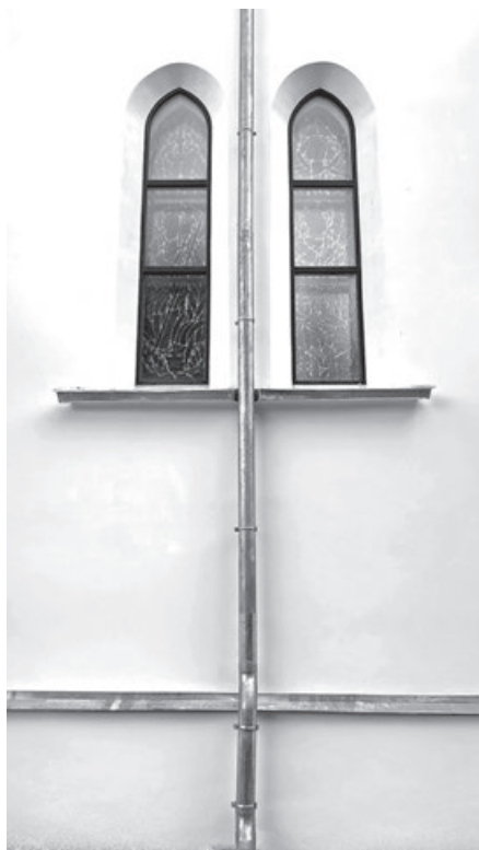
Przeszklenia ochronne witraży zabezpieczające przed niekorzystnym oddziaływaniem warunków atmosferycznych wraz z odnowionymi elementami obróbki blacharskiej
