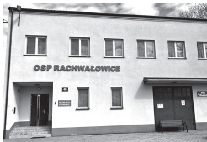
Odnowiony budynek OSP w Rachwałowicach
