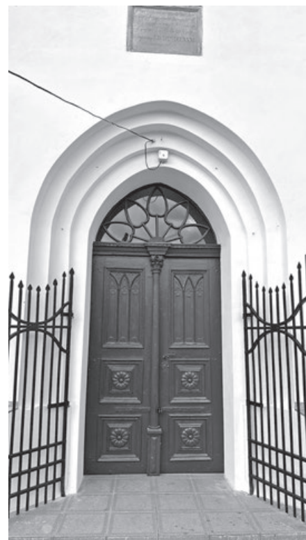
Główne drzwi wejściowe po przeprowadzonej konserwacji wraz z naprawą okuć i uszczelnień
