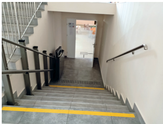
Platforma przyschodowa do poziomu niższego
