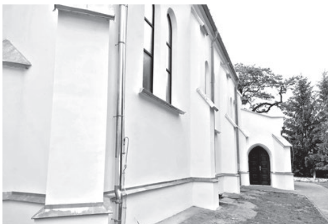
Północna strona elewacji kościoła z widocznymi nowymi elementami obróbki blacharskiej oraz odnowioną instalacją odgromową
